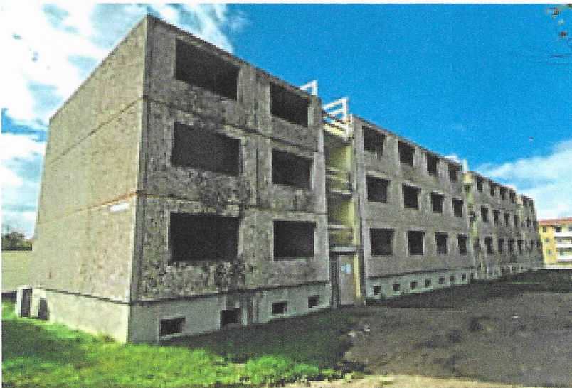
Bild 2: Zwischenzustand: Die oberen beiden Etagen wurden abgetragen und ein Gebäudesegment abgerissen
